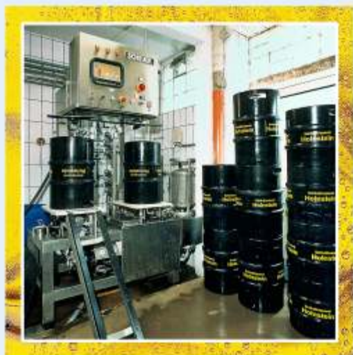
Moderne Fassabfüllanlage, die auch den grössten Durst befriedigen kann.
